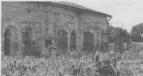
L'abbaye de l'Étoile est un ancien monastère de moines cisterciens, à Archigny. (Photo cor. NR-CP, Carole Pourveau)
