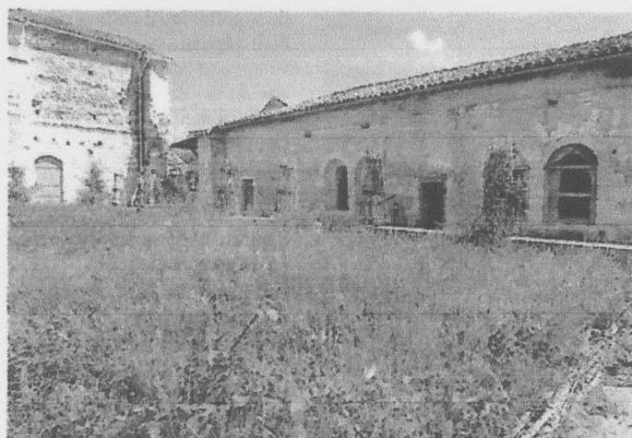
Les bâtiments de l'abbaye de l'Étoile sont en mauvais état. (Photo cor. NR-CP Carole Pouvreau)
